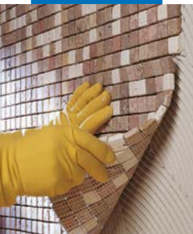
Aanbrengen van marmermozaïek 2x2 op een wand
