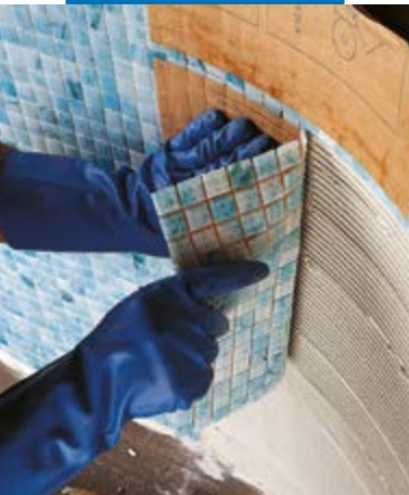
Aanbrengen van glasmozaïek 2x2 in een zwembad met Adesilex P10 gemengd met Isolastic verdund 1:1 met water
